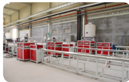
PE Pipe Line
